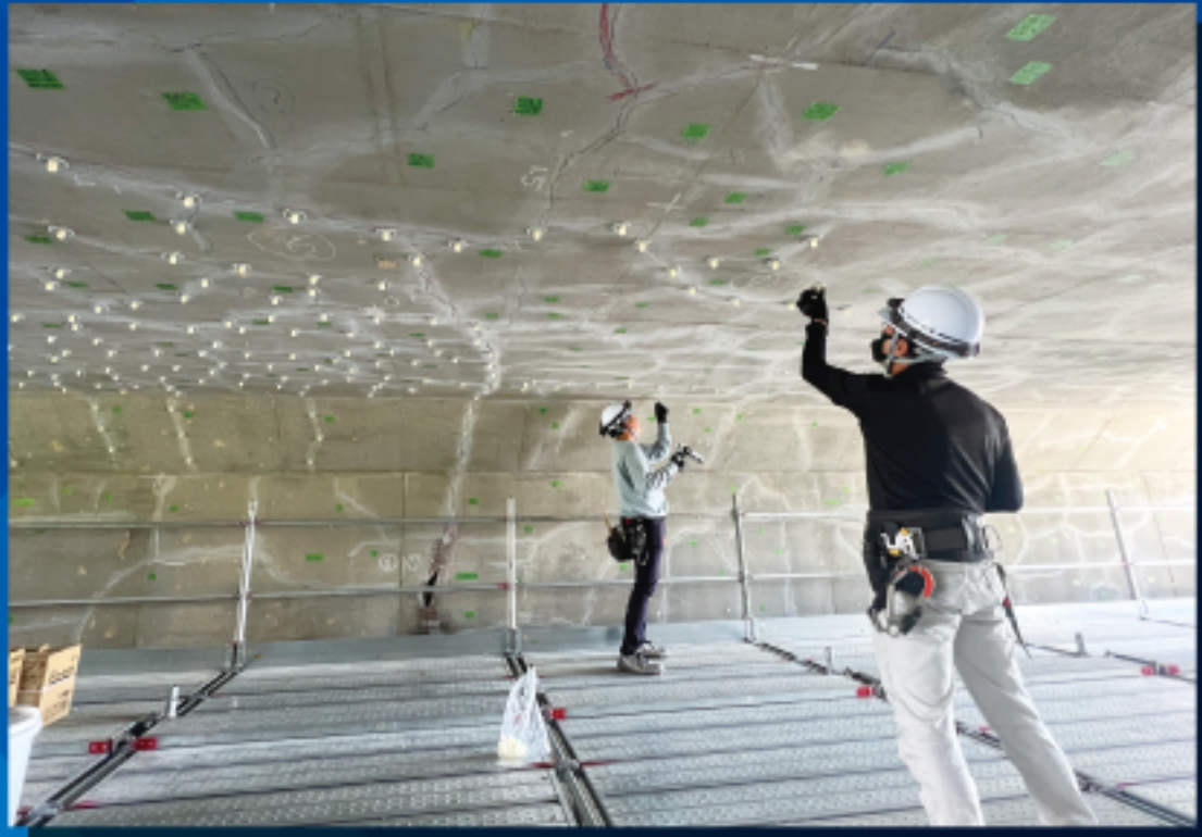
コンクリート補修工事
