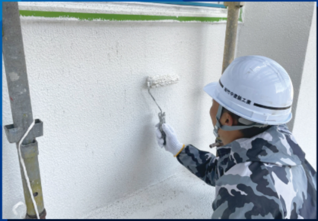
住宅塗装工事
