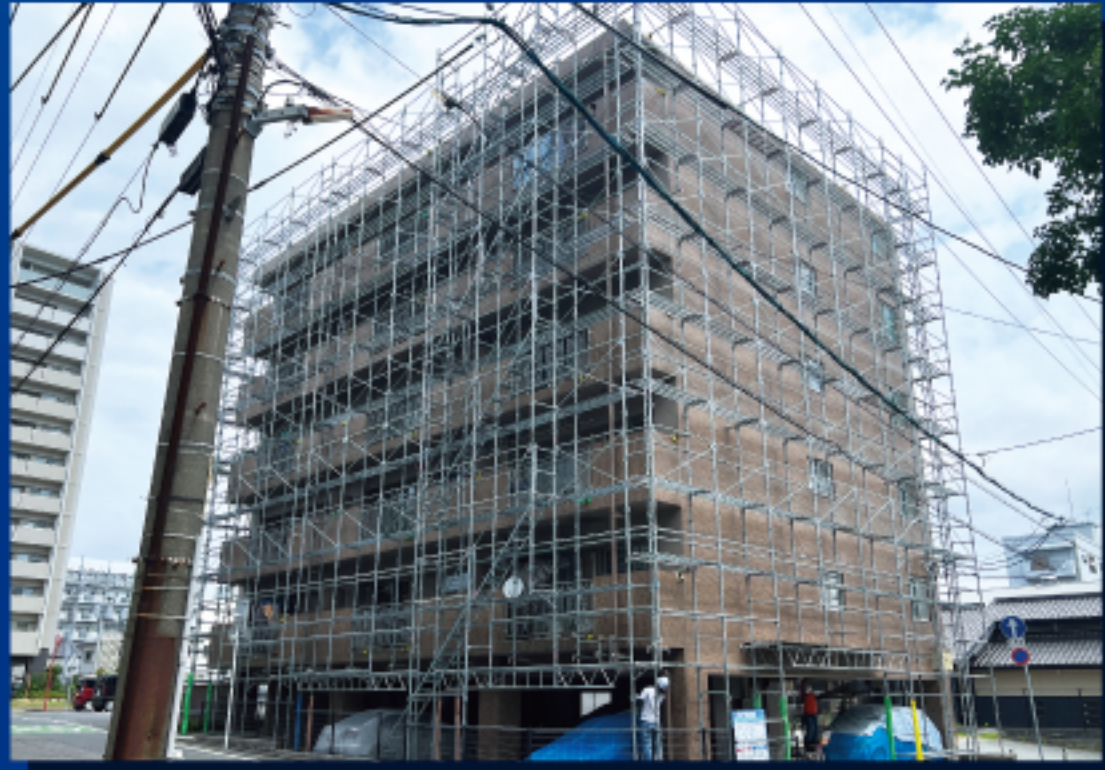
外壁改修工事
