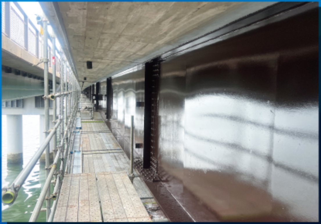
橋梁塗装工事
